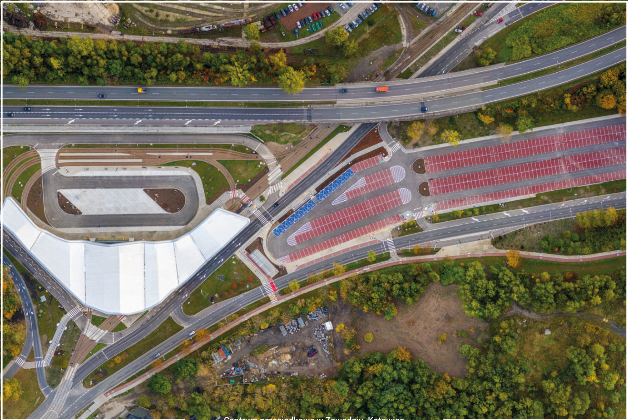
Centrum przesiadkowe w Zawodziu, Katowice
