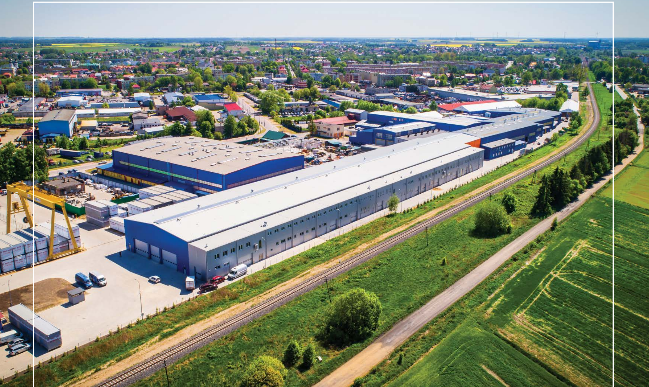
Fabryka budynków modułowych Unihouse, Bielsk Podlaski, Polska
