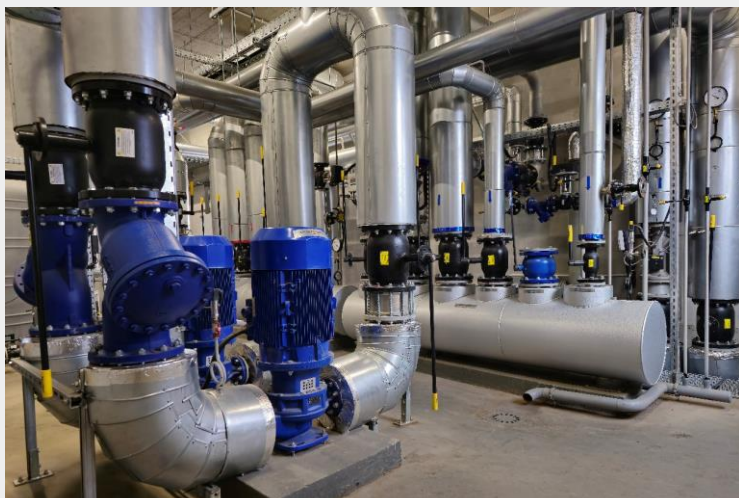
Modernizacja dwóch kotłowni i budowa jednej kotłowni dla PEC w HAJNÓWCE
