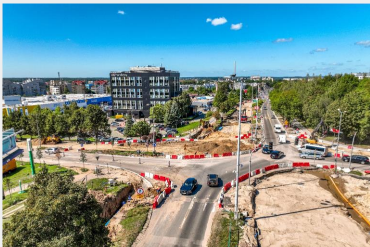
Modernizacja ul. Plażowej oraz ul. Pstrowskiego OLSZTYN
