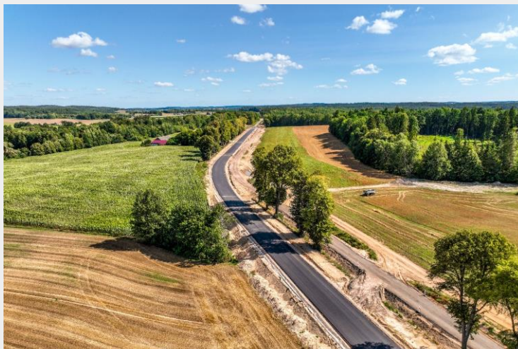
Rozbudowa drogi wojewódzkiej nr 513 na odcinku Lidzbark Warmiński – Wozławki
