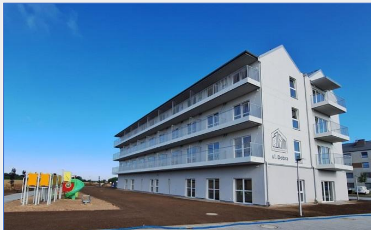
BUDYNEK WIELORODZINNY SIM, ŚWIDWIN, POLSKA
