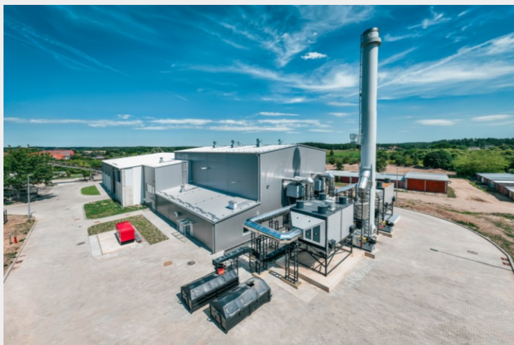
ROZBUDOWA SYSTEMU CIEPŁOWNICZEGO W ORZYSZU
