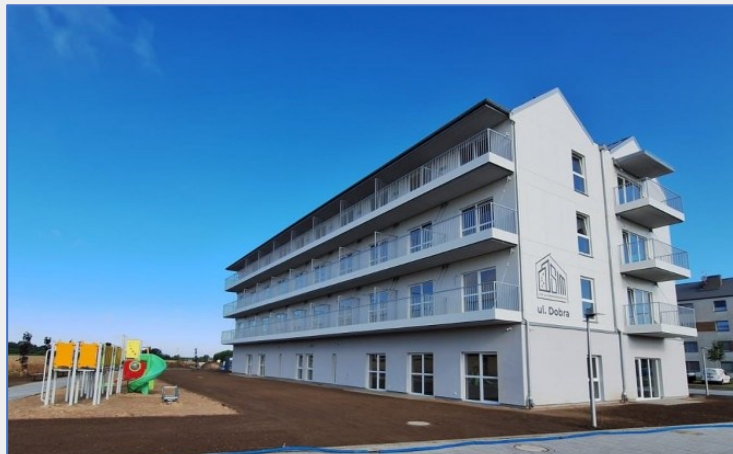
BUDYNEK WIELORODZINNY SIM, ŚWIDWIN, POLSKA
