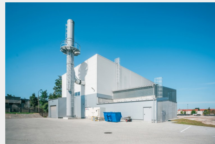
BUDOWA KOTŁOWNI SM ŚWIT W ELKU
