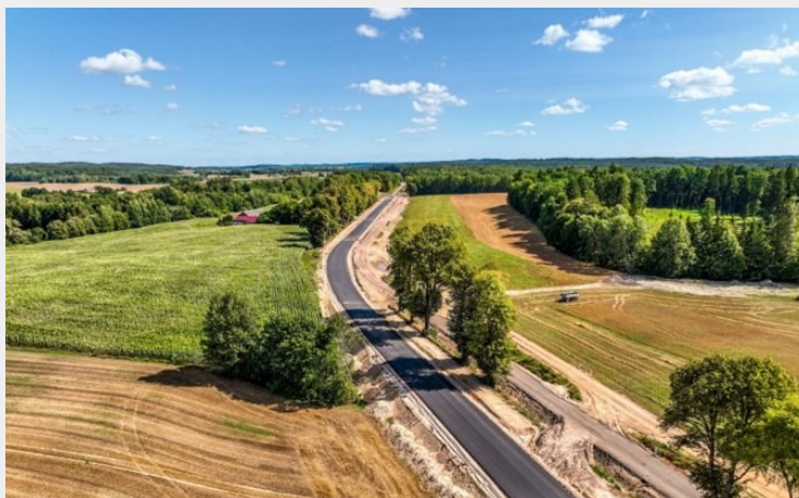
ROZBUDOWA DROGI WOJEWÓDZKIEJ NR 513
