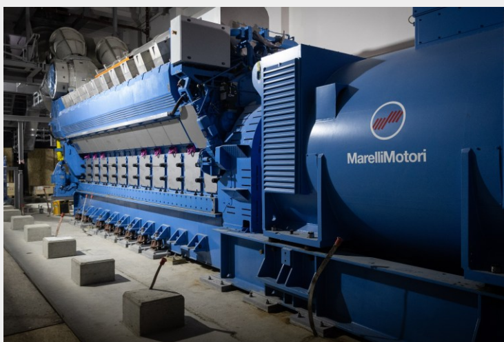
BUDOWA UKŁADU KOGENERACYJNEGO W ELBLĄGU*
