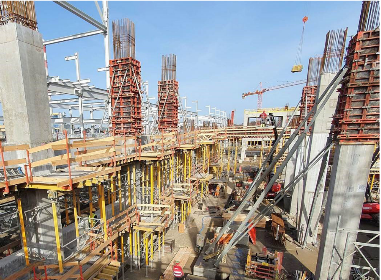
Budowa kompleksu Polimery Police, Police, Polska
