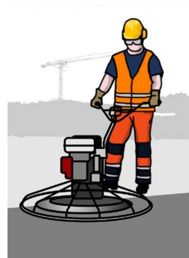
Rys. 5. Bezpieczeństwo i higiena pracy przy obsłudze zacieraczki do betonu
